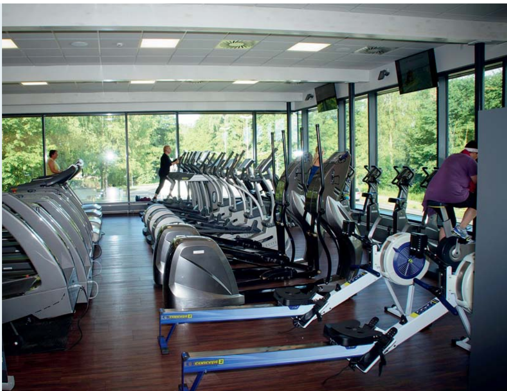
Die Deckenbinder werden hinter der gläsernen Fassade von Stahlrohren getragen. Mit ihrer weißen Lasur fügen sie sich unauffällig in die Kassettendecke ein.
